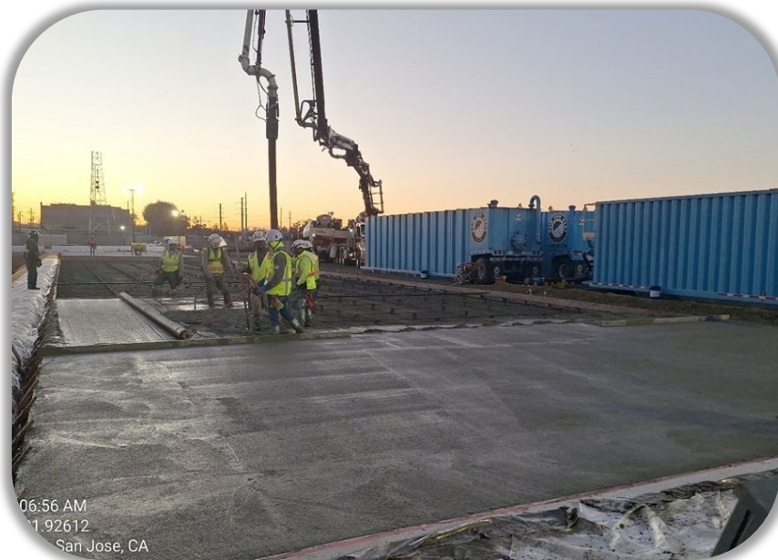
Concrete Pour for Access Road
