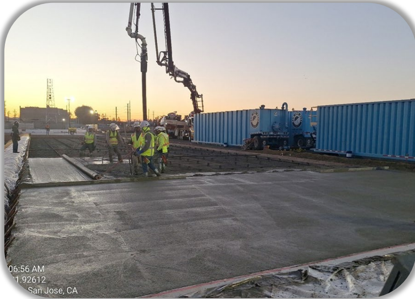
Concrete Pour for Access Road
