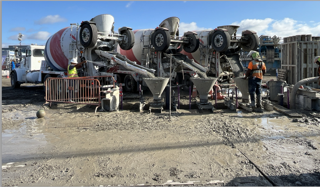
Multiple concrete trucks for Y-Panel 12 hour pour
