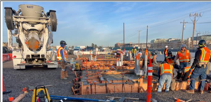
Concrete Pour of Pads at Power Drop #3
