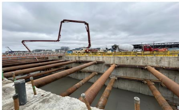
Concrete Pour of U-Wall Working Slab 3C
