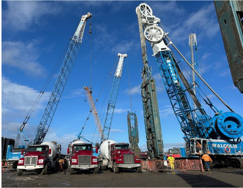
Caterpillar Shaft Concrete Pour - Discharge of Concrete
