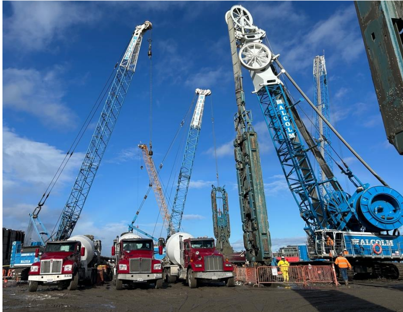
Caterpillar Shaft Concrete Pour - Discharge of Concrete
