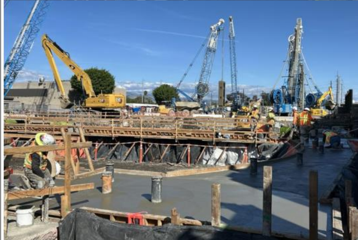
Concrete Pour for Phase I Construction of Cap Beam & Top Struts
